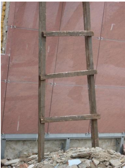
Самодельные деревянные приставные лестницы, сбитые гвоздями, без врезки ступенек в тетивы
