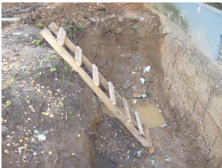
Деревянная приставная лестница, сбита гвоздями, без врезки ступенек в тетивы без оковок с острыми наконечниками для установки на земле
